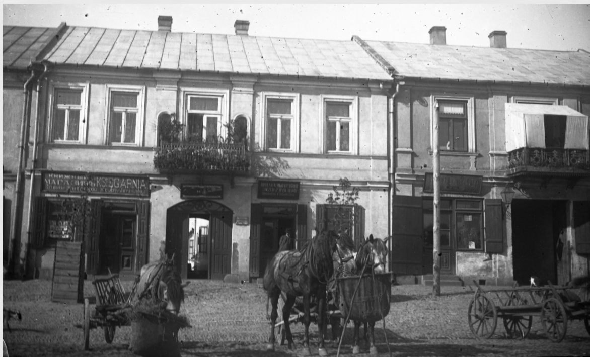
Fot. 12. Jędrzejów, rynek. Dom Przytkowskich, widok elewacji frontowej. Obecnie Plac Kościuszki. Po prawej stronie kamienica zamieszкана przez rodzinę Zylberszaców. Na balkonie widoczna kuczka, zbudowana na święto Sukkot. Fot. Feliks Przytkowski, 1912 r.
